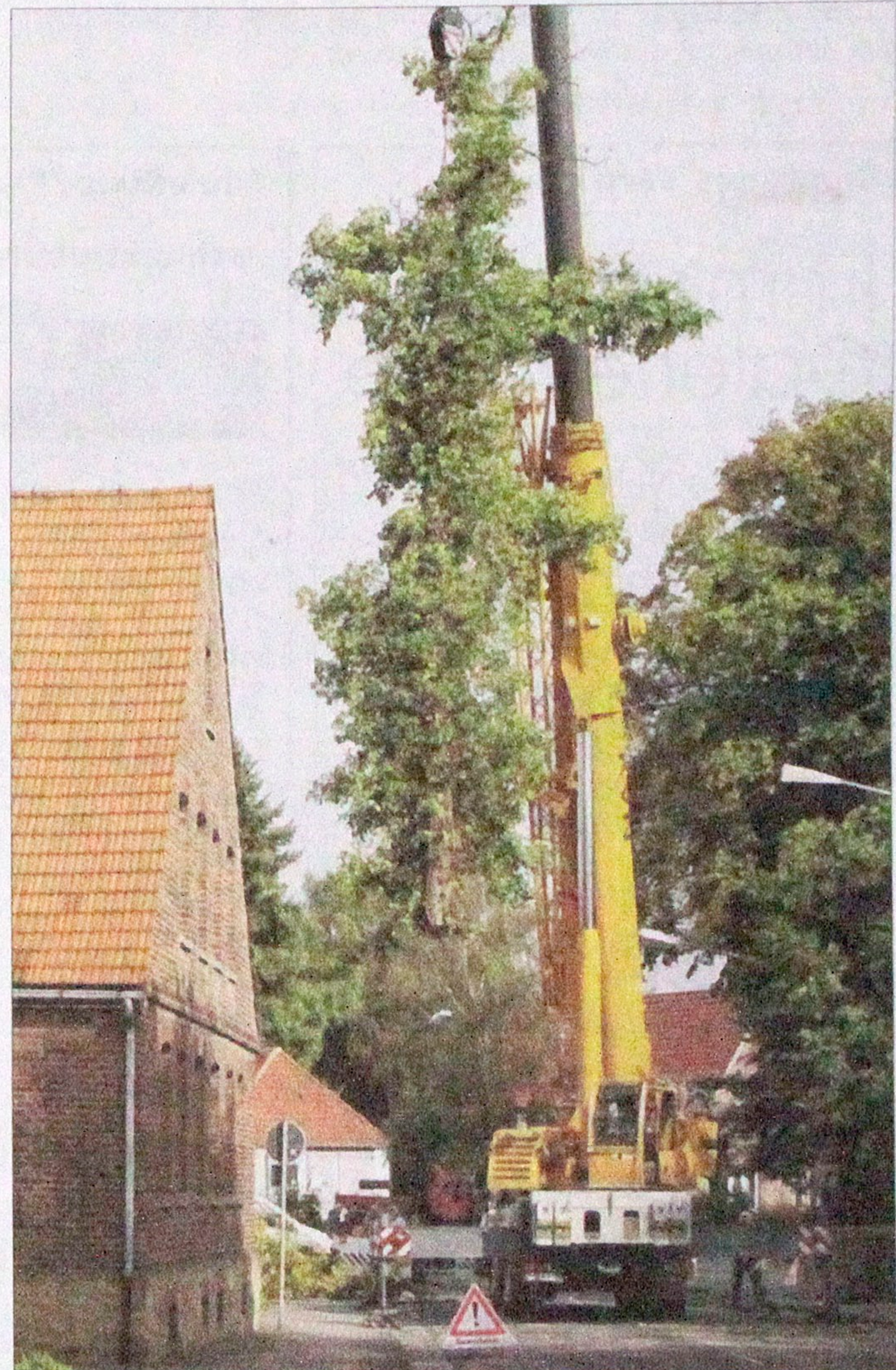
Der tonnenschwere Kran wuchtete einen Baumriesen komplett über die Barkhausener Straße.
